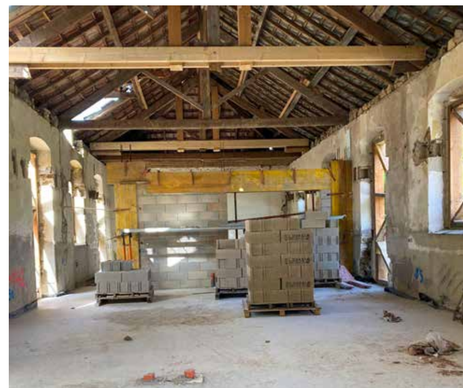
La dalle a été coulée et les premiers murs dessinent ce que sera la configuration des locaux.
